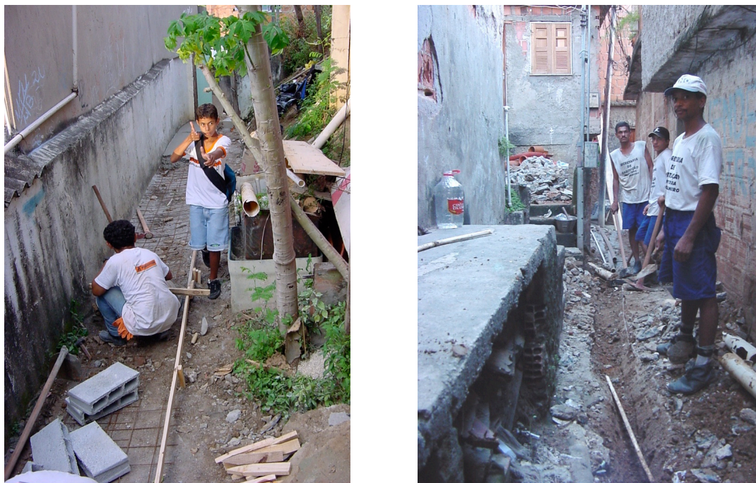
Figure 12 : Travaux de voirie dans les rues du Morro da Providência, programme Favela-Bairro, 2004 (crédit: Mauricio Hora).
