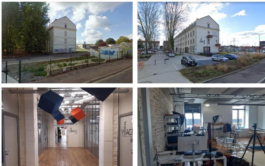
Figure 12. L'Inkub à Nevers avant et après la réhabilitation du site.
