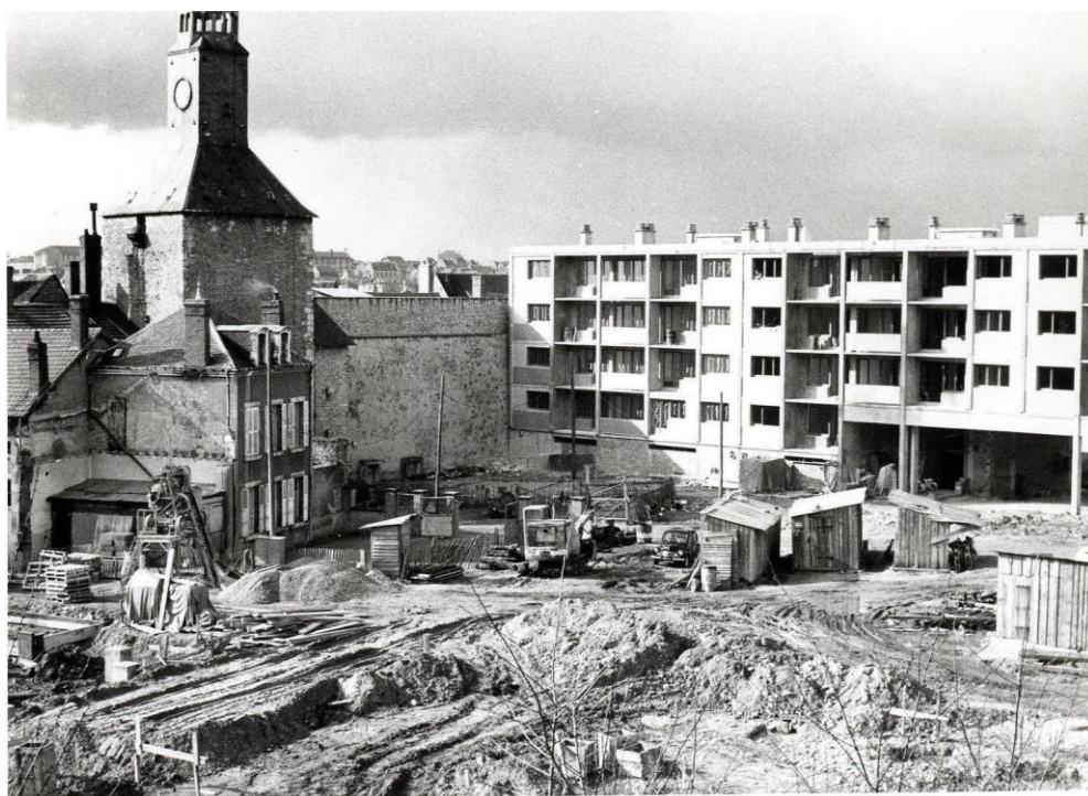
Figure 12. L'opération « Tunnel-Château » entre 1965 et 1967. © Cercle historique du pays de Vierzon
